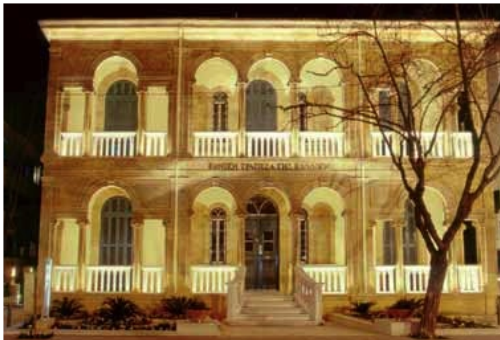
Το ανακαινισμένο διατηρητέο κτίριο στη Λευκωσία, όπου στεγάζεται η Διοίκηση
