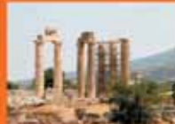
Στήριξη των έργων αποκατάστασης στέγης από τους 4 κίονες στο Ηρώ του Διός στο Νερό
